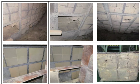
图 3 模块腐蚀情况
